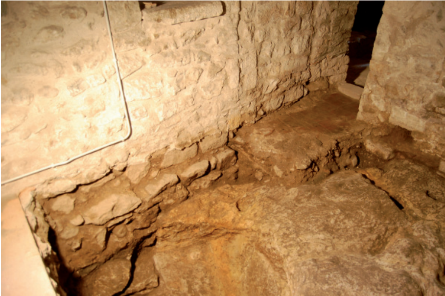
FIGURA 13. Excavació de la «cava». En primer terme surt part de la paret del col·lector sota el mur actual. Al fons a la dreta, el paviment de toves i la porta d'accés al micvé.
