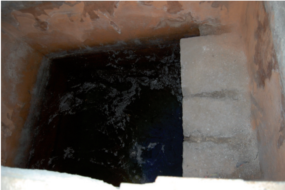
FIGURA 15. Detall interior de la cisterna, on s'aprecien les lloses de pedra que formaven el replà d'accés.
