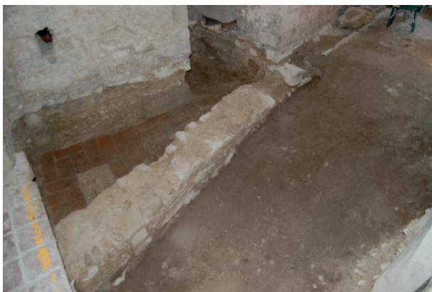
FIGURA 10. Detall del «vestidor» amb el paviment de toves. Al fons, el mur que el separava de la cisterna, on es pot observar el mur antic en l'arrencament de la base.
