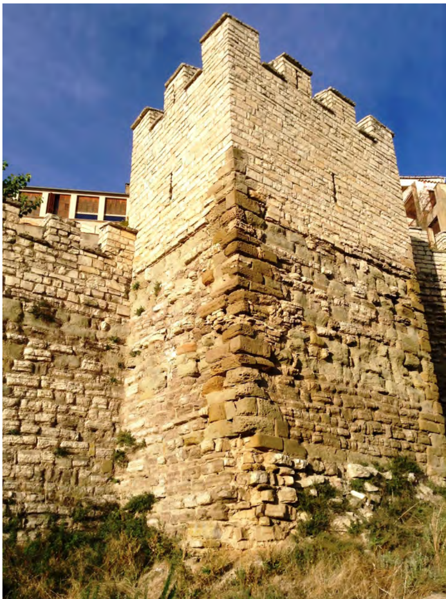
FIGURA 4. Torre dita dels jueus, al mur de sol ixent, al carrer de la Barbacana, molt a prop del call Jussà. (Fotografia: F. Xavier Rivera Sentís)
