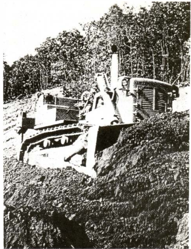
El treball amb maquinària pesant, com els "bulldozers", facilita l'erosió del sòl.
