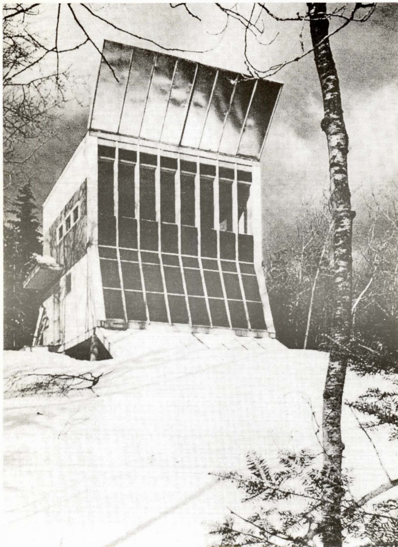
En la fotografia hom pot apreciar la importància de l'orientació de l'edifici per tal de captar l'energia solar el màxim d'hores possible anualment. La gran obertura vidrada, orientada al sud, permet recollir la radiació solar i mercès a un sistema combinat de reflectors, emmagatzemar l'energia.
