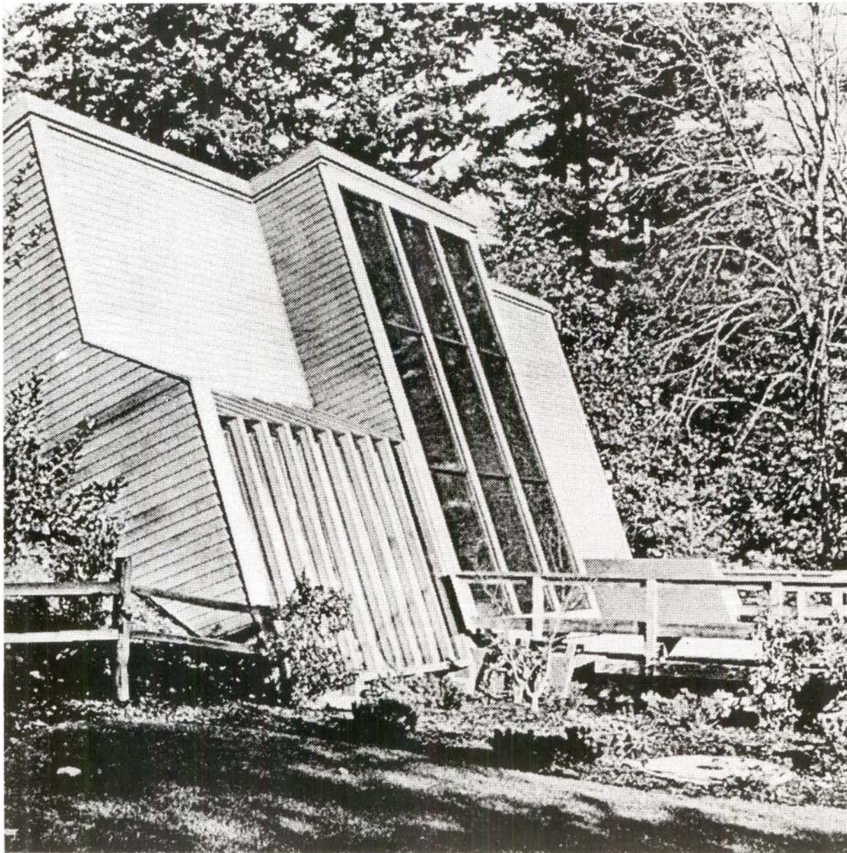
En aquesta edificació hom combina d'una part l'efecte hivernacle (sistema solar passiu), que permet recollir l'energia solar durant tot l'any amb un d'actiu, (paràbols de concentració tèrmica), el qual fa possible d'obtenir vapor d'aigua, que és emprat a l'hivern per escalfar i a l'estiu per a refrigerar (sistema Rankine).
