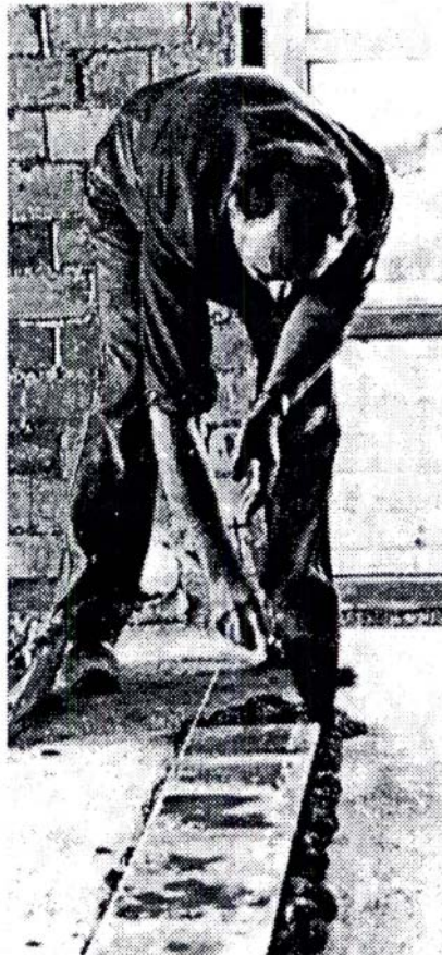
L'execució de la mestra és una operació fonamental, prèvia a la col·locació del mosaic hidràulic.
