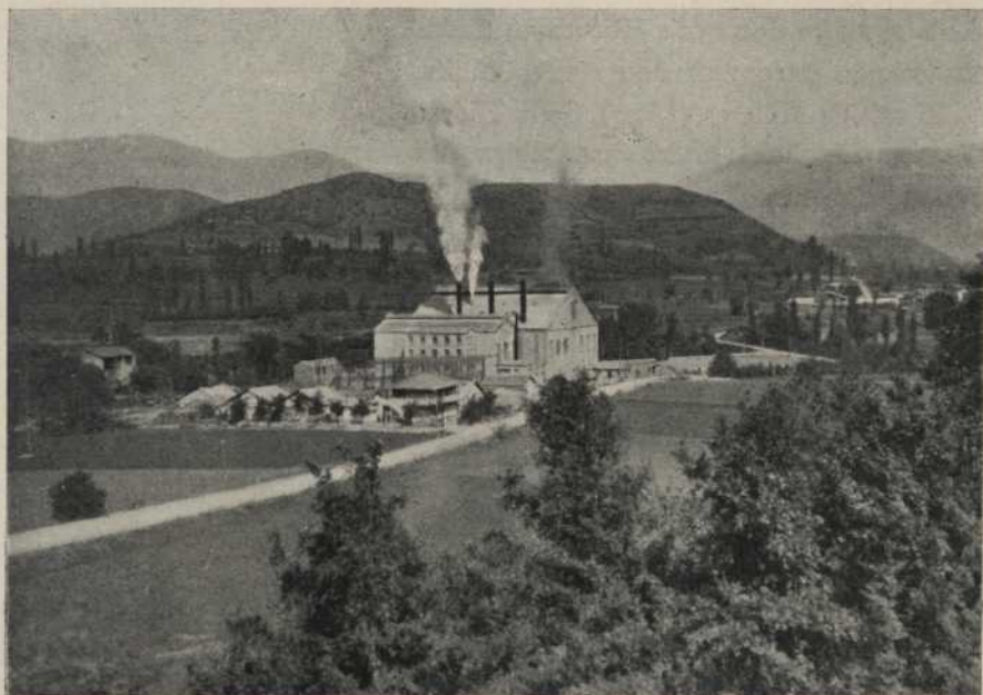
Fig. 3 Central tèrmica d'Adrall
