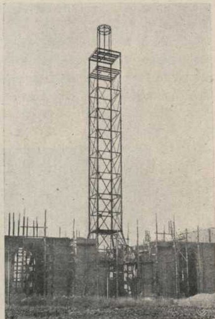
Fig. 10 Estructura de la torre del Palau d'Art Textil
