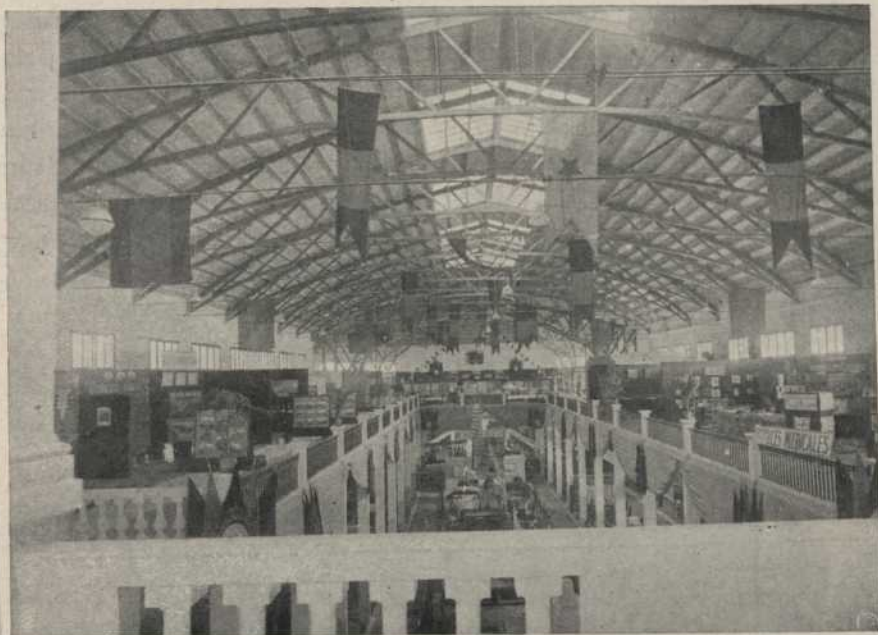
Fig. 5 Encavallades de 20 m. de llum del Pavelló de Bèlgica
