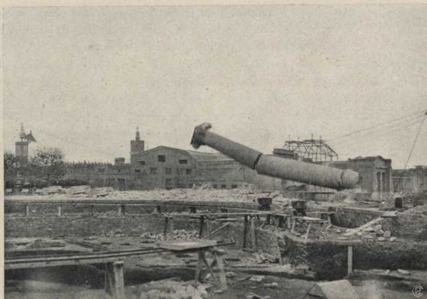
Fig. 13 Caiguda d'una de les quatre columnes
