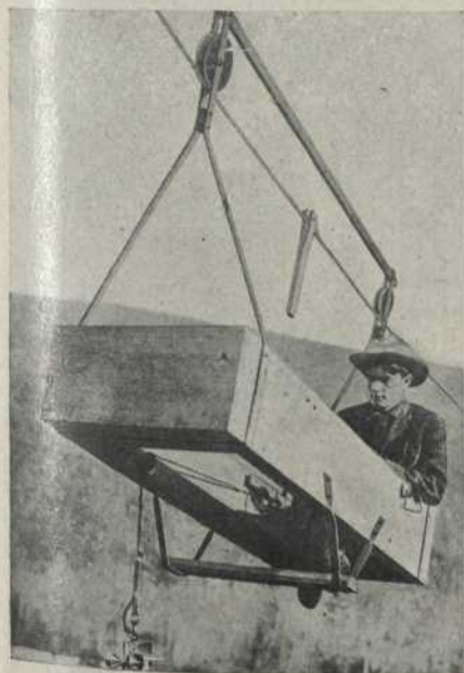
Fig. 4 - Carro sostingut per un cable d'acer sobre un torrent. Ací les mesures es fan tot còmodament; l'operador detura el vehicle espatadament per tal d'observar l'acció de les aigües sobre el molinet en el lloc escollit.
