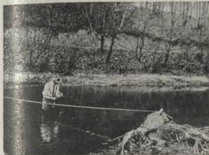
Fig. 2 - Per mesurar el dèbit d'un riu poc caudalós, l'operador estén un cable d'una riba a l'altra i va prenent, al llarg de la línia així traçada la profunditat del riu.
