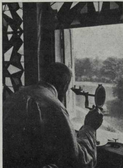
Observació dels núvols amb el teodolít i una capa d'aigua instal·lada a distància.
