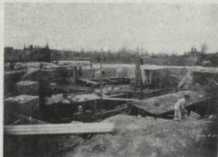
Fonaments d'un pilar sortint de terra primeries de 1887)
