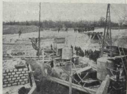
Caixes d'aire comprimit per als fonaments (1 de maig de 1887)
