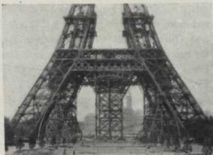
Fixació de la primera plataforma
