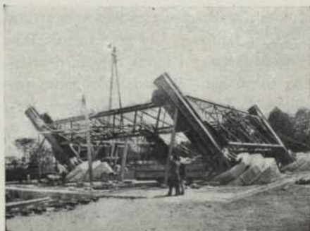
Enbigat de base d'un dels pilars (1888-89)
