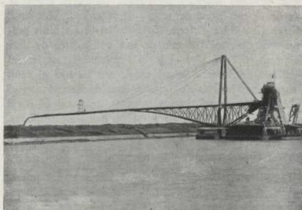
Una de les dragues emprades en l'enfondiment del canal
