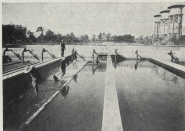
Neteja dels dipòsits de decantació de les aigües de Port-Said
