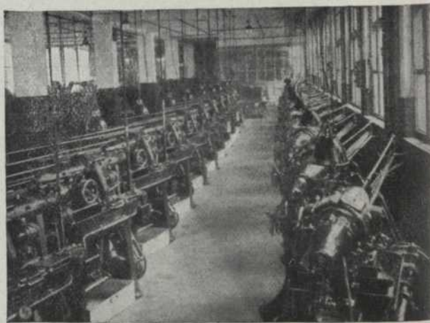
Fig. 2 Vista d'un taller amb accionament individual ( Fot. Siemens )
