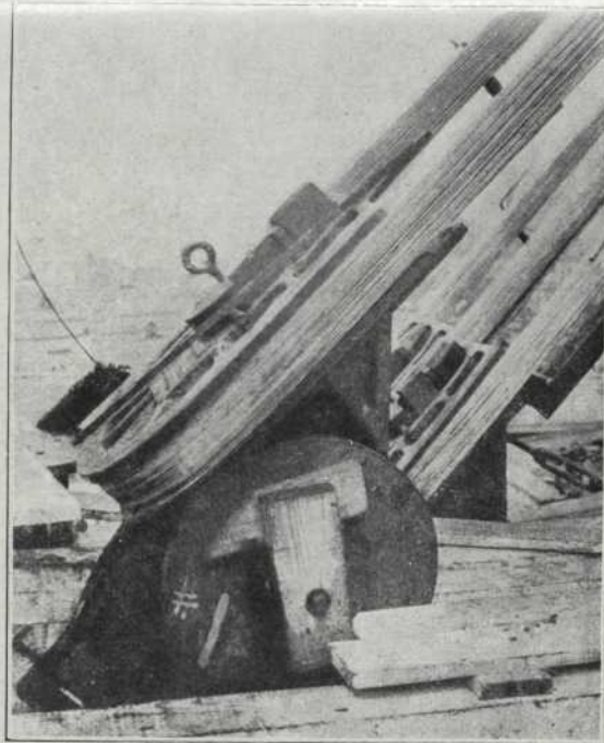
Fig. 7.—Lligament del cable al tornapunts
