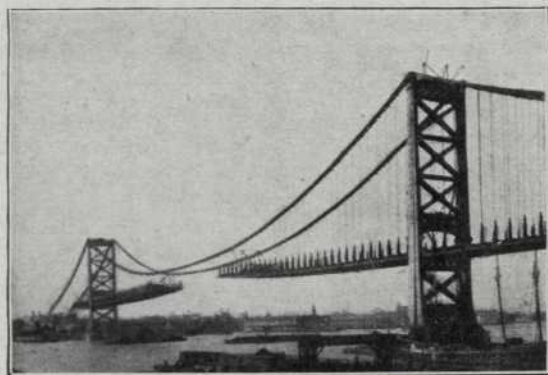
Fig. 2.—Primera fase del pas on es mostra la corba revertida en la corda inferior
