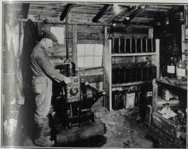
Fig. 16 Motor i instal·lació d'illuminat elèctric del galliner de Beltsville (Estats Units)
