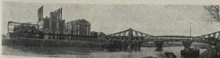
Fig. 9. Vista general de la Central de d'Yvry.
