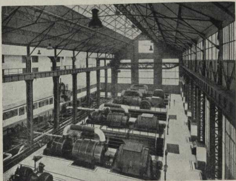
Fig. 13. Central d'Ivry Vista interior de la sala de màquines.
