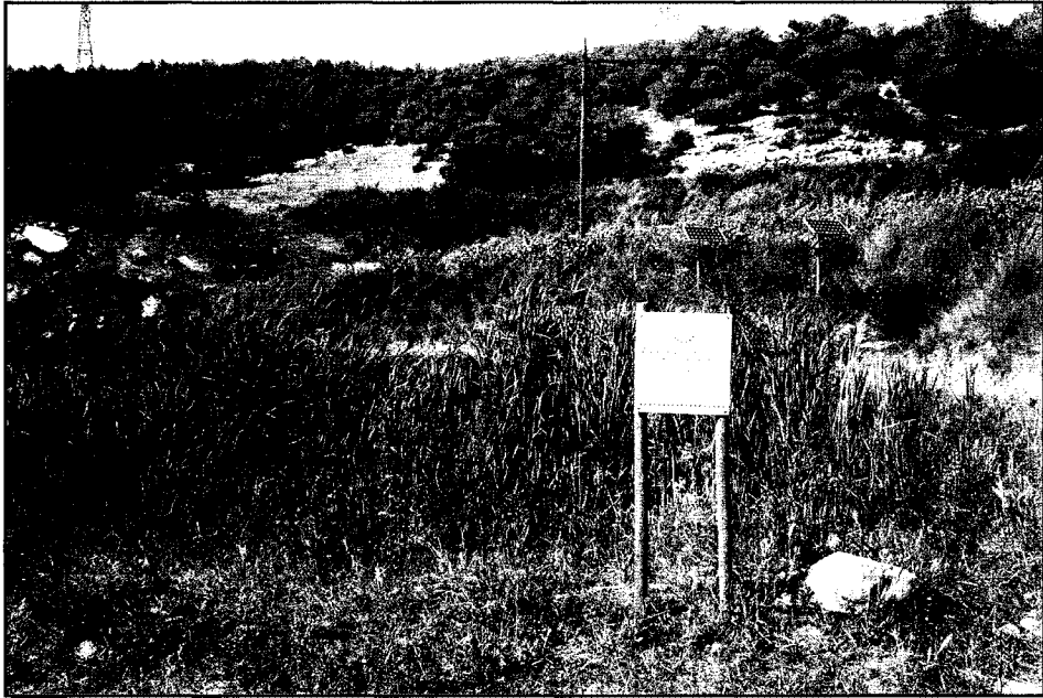
Mas Vendrell. Caves Albet i Noya. Sant Pau d'Ordal. Bassa de la depuradora d'aigua residual. Es destaquen les dues plaques solars que forneixen l'energia per moure un aparell remenador de l'aigua (fotografia de Narcís Rucabado).
