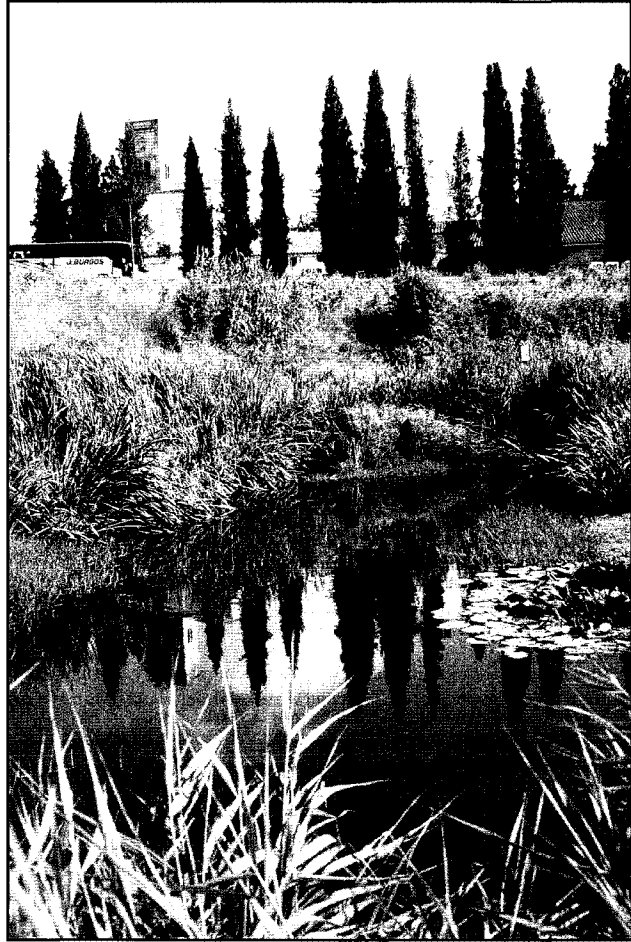
Mas Vendrell. Caves Albet i Noya. Sant Pau d'Ordal. Bassa de la depuradora d'aigua residual (fotografia de Narcís Rucabado).
