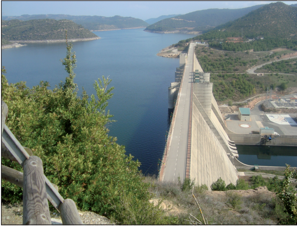
Presa de l'embassament de Rialb, de 99 m d'alçada i 606 m de longitud. L'embassament es trobava al 73 % de la seva capacitat.
