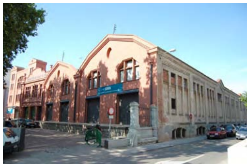
Figura 7. Edifici Acondicionaments i Docks de 1897. Conservat, actual seu de l'ESDI (zona número 5)
