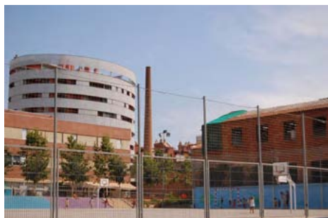
Figura 9. Vista general zones 20 i 29. Pisos de nova planta, conservació d'elements industrials i un nou equipament públic
