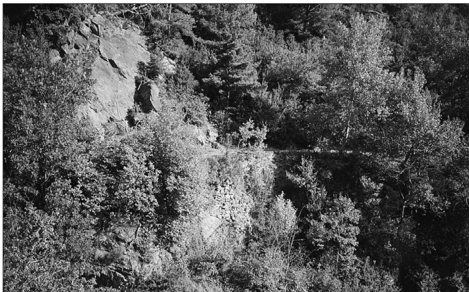
Fragment del camí de Toses al Pas del Vell. Notem un dels murs de contenció del camí.
