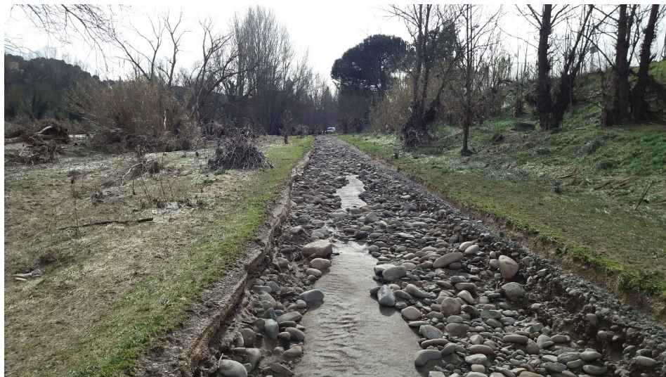
Fig. 3. Danys causats per la riuada del Ter al camí vora riu al barri de Sant Ponç (Girona)
