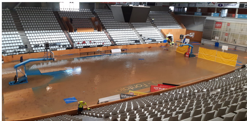
Figura 5. Inundació de la planta de nivell pista del pavelló municipal de Girona Fontajau
