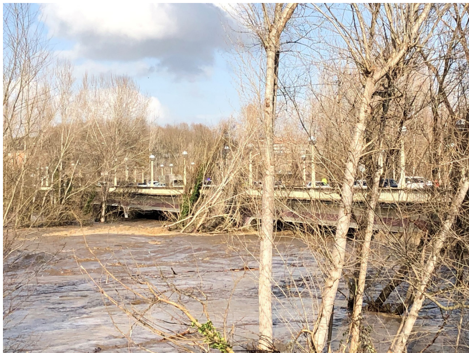
Fig. 4. Acumulació d'arbres arrossegats per la riuada al pont de Fontajau (Girona)
