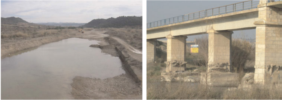
Figura 2. Esquerra: extracció d'àrids al riu Siurana aigües amunt de la confluència amb l'Ebre (Garcia); dreta: pont descalçat al tram baix del riu Segre (Aitona)
