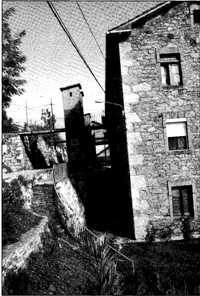
Foto 3. Habitatges del carrer Santa Bàrbara amb les escales i els WC exteriors.
