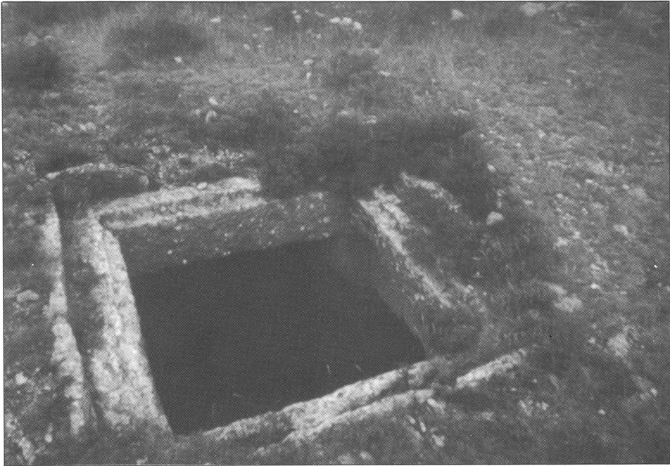
Nevera del Tossal de la Nevera (Cati). Detall de l'obertura superior per on s'introduïa la neu.
