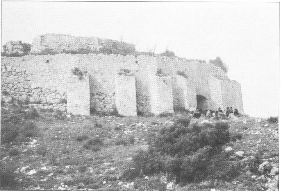
Cava de Don Miguel (Bocairent). És una de les construccions per a la conservació de la neu més interessants. S'hi veuen els murs potents que prolonguen i protegeixen el seu excavat.
