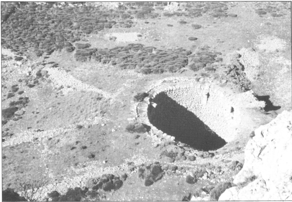
Nevera del Pla de la Casa a la Serella. S'hi veu, a l'esquerra, les plataformes que facilitaven la recollida de la neu.
