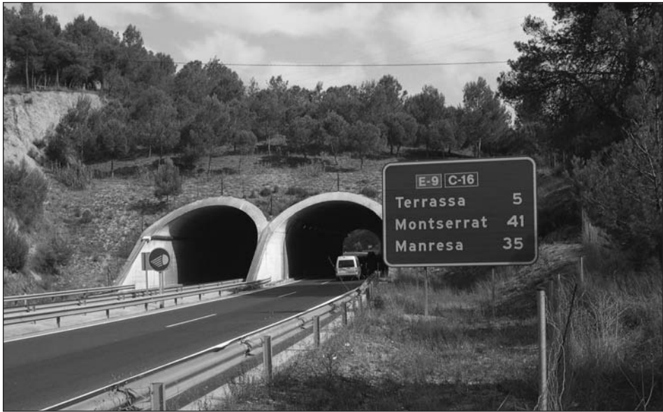
Figura 2 Un fals túnel de l'autopista Rubí-Terrassa, a la via C-16 (E-9)
