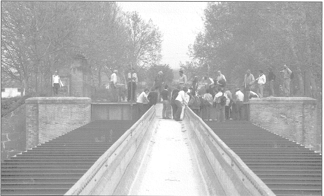
El grup inspeccionant la part superior del Pont de Ferro (l'aqüeducte del canal sobre el Sió). El canal central superior descobert permetia el pas dels troncs procedents del Segre amb destinació a serradores o papereres com ara la Forestal d'Urgell de les Borges Blanques.
