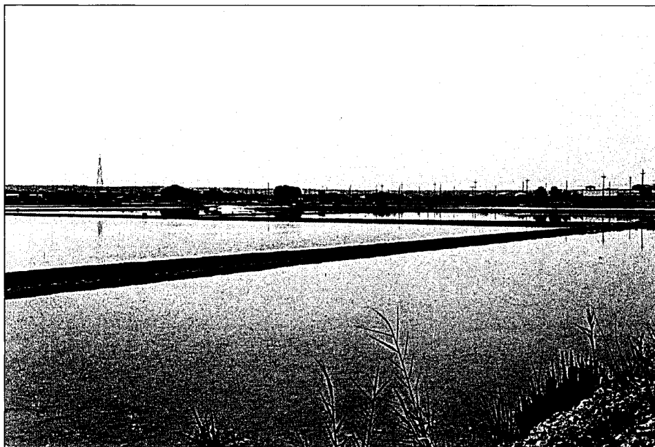
Figura 10 Dipòsits d'evaporació a l'explotació de sulfat magnèsic de ses Fontanelles
