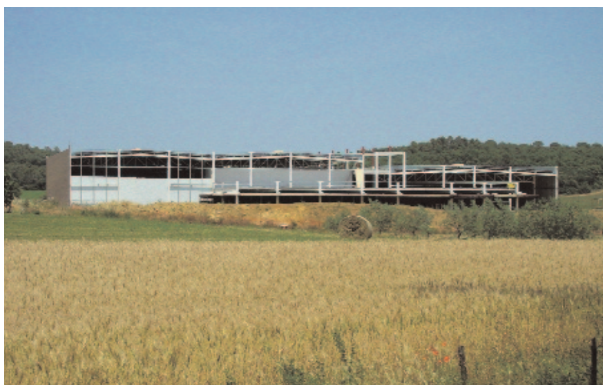
FIGURA 1. Edifici CENTA en construcció, a Monells (Girona).
