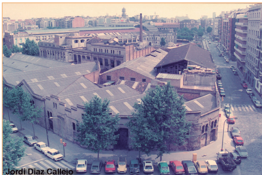
FIGURA 6. Imatge del conjunt fabril de la Refinería de San Luis a finals de la dècada del 1980.
