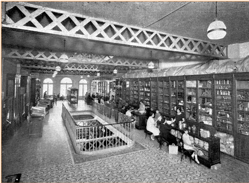
Figura 4. Interior de la Unió Cooperativista Barcelonesa els anys 1930, al carrer de Villarroel, 163. Fundació Roca i Galès.
