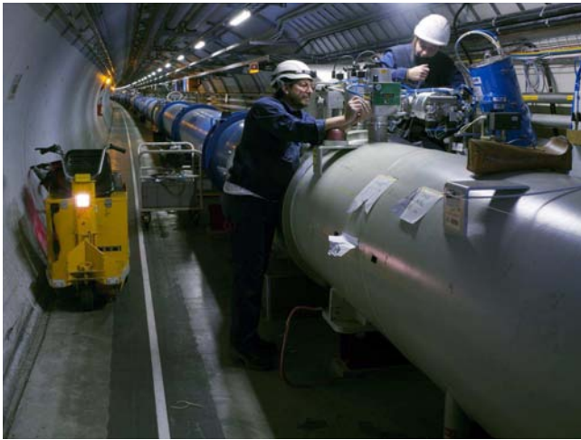
Figura 2: El túnel de l'LHC, amb uns dipòls superconductors
