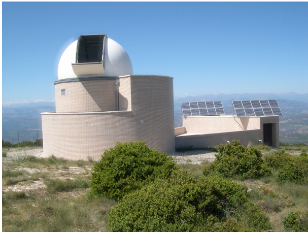
Figura 3: Edifici de l'Observatori Astronòmic del Montsec (OAM). A l'esquerra, l'edifici principal amb la cúpula de 6,15 metres de diàmetre que aixopluga el telescopi de 80 cm. A la primera planta de l'edifici, a la dreta, es troba la sala de control. A la planta baixa hi ha el magatzem i el taller. A la dreta i al fons de la fotografia es veu l'annex de serveis on es troba el sistema de generació elèctrica, que inclou un conjunt de plaques solars
