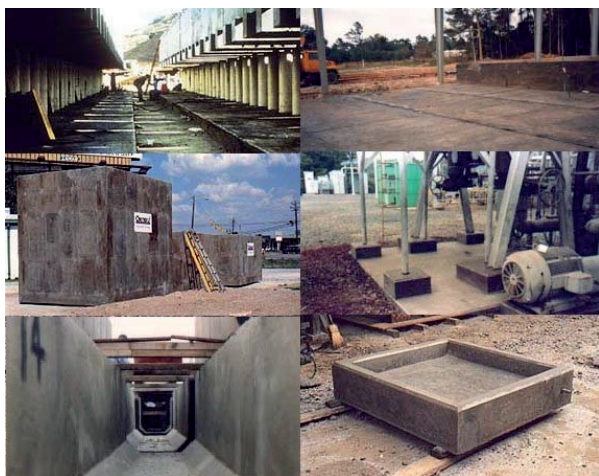
FIGURA 3. Diverses aplicacions del formigó de sofre al Canadà i als Estats Units: paviments industrials, recobriments, contenidors, elements prefabricats.
