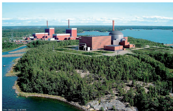
FIGURA 12. Fotomuntatge. Olkiluoto (Finlàndia). Dues centrals nuclears en operació, 2 x 840 MWe, al costat d'una tercera en construcció, EPR-1600 MWe. Aquest emplaçament tindrà una potència de 3.280 MWe i generarà uns 24.000.000 MWh d'energia elèctrica a l'any, el doble de l'energia eòlica generada en tot Espanya el 2004.
