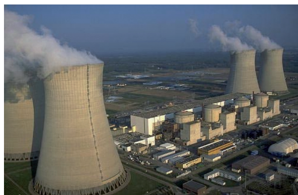
FIGURA 18. Dampierre-en-Burly (França), on hi ha quatre centrals nuclears PWR de 900 MWe cada una. Potència total instal·lada a l'emplaçament: 3.600 MWe (Chambrú, 2005).
