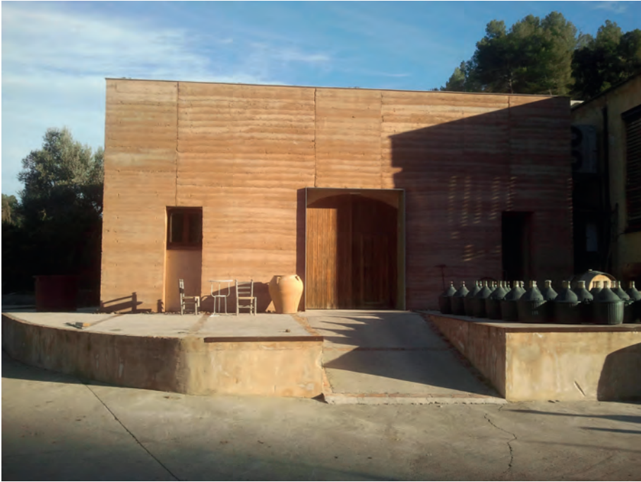
FIGURA 5. Model de bioconstrucció en un celler construït amb plantes subterrànies per vinificar i dur a terme els moviments del vi per gravetat (Mas Martinet Viticultors, Falset)
