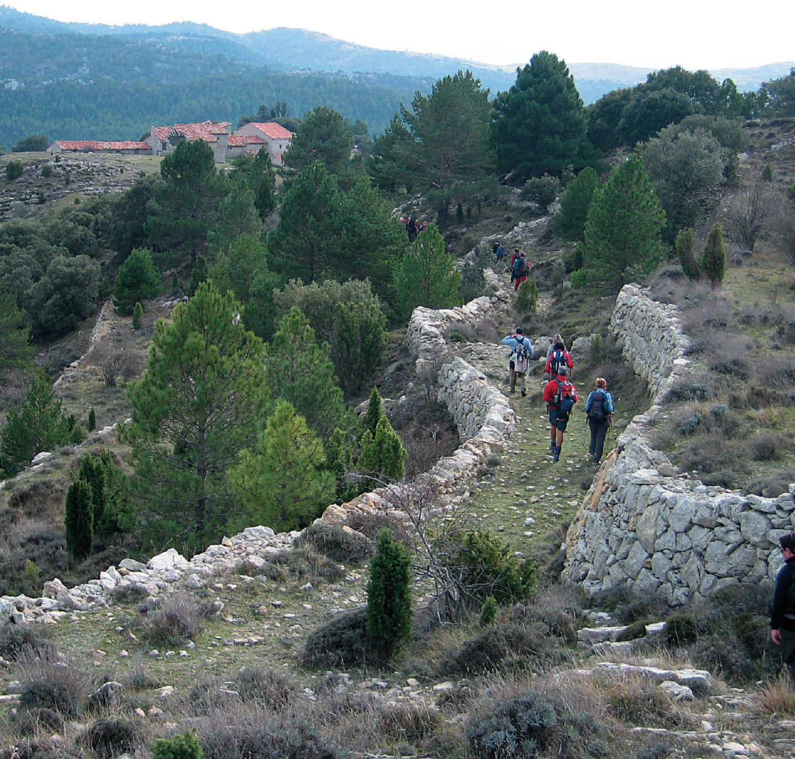
Els marges de pedra seca delimitaven els camins que unien els masos, pobles i llogarets de les comarques d'interior, com aquest camí de ferradura al Tossal d'en Canadé, al Mas Blanc (Els Ports).
