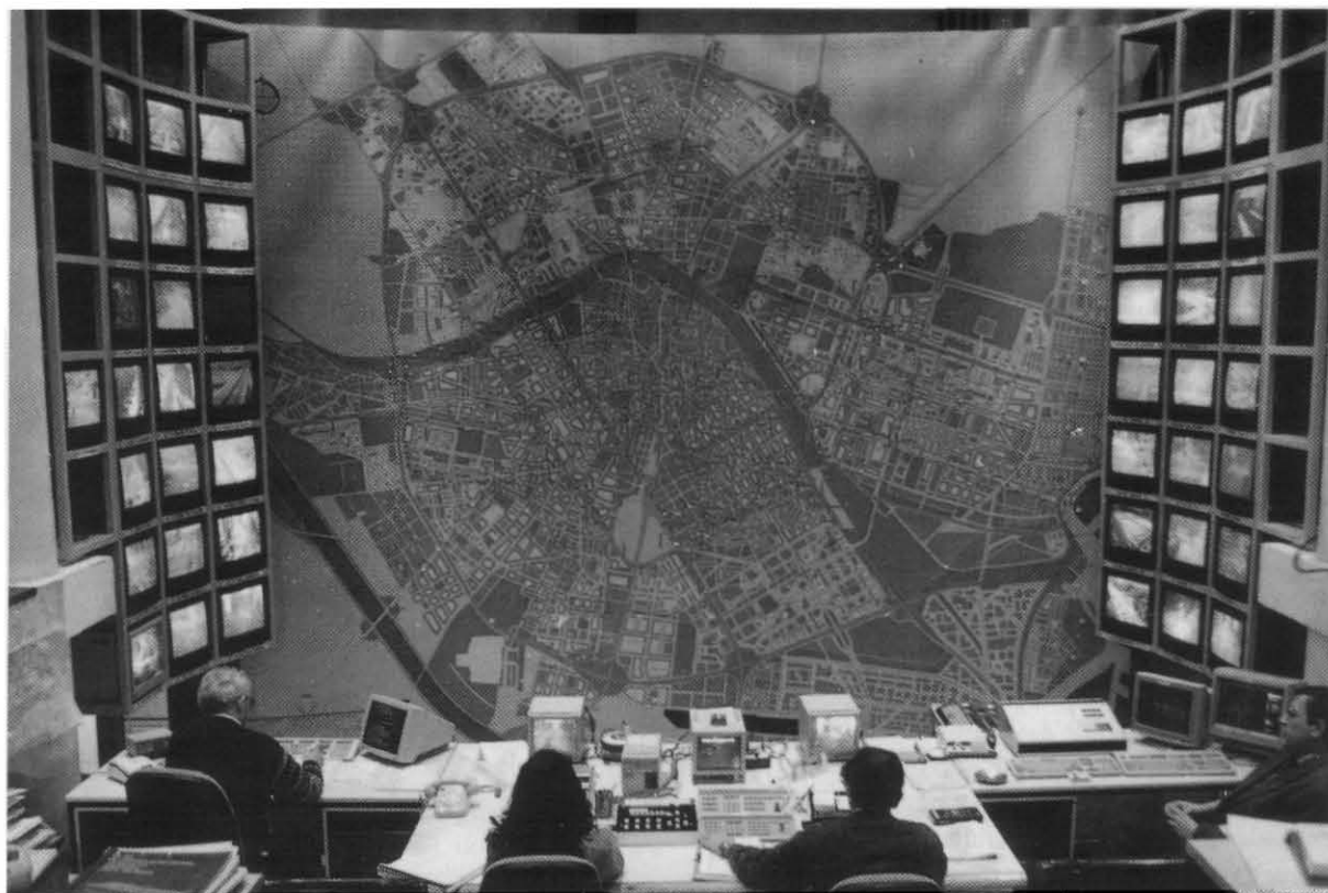
Circuit tancat de càmeres de TV, el sistema més habitual de control de trànsit
