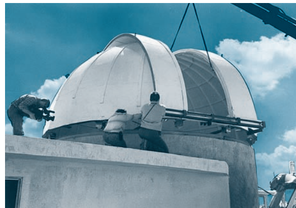
Col·locació de la cúpula de 6 metres (abril 1997).
