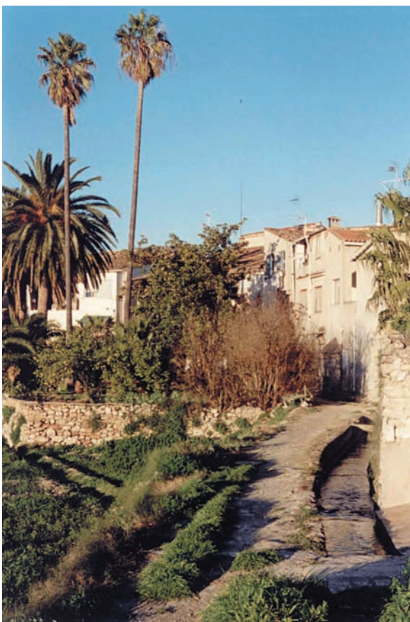
Foto 2: La séquia del Port per Atzeneta. L'aigua que condueix aquesta séquia es reparteix pel sistema del rellotge de peus.
