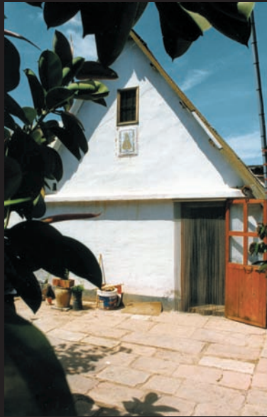
Barraca de ca Torres. Marítim-Vera de València. Aquesta menuda barraca està situada molt a prop de la de Belloch. En el moment de la fotografia (maig del 1998), estava habitada.
