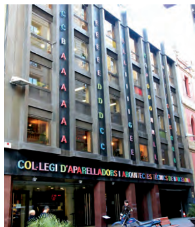
Figura 6. Façana del Col·legi d'Aparelladors i Arquitectes Tècnics de Barcelona, al carrer del Bon Pastor, número 5, amb el disseny del nom a càrrec de Joan Brossa (1993). Font: fotografia de l'autor.
