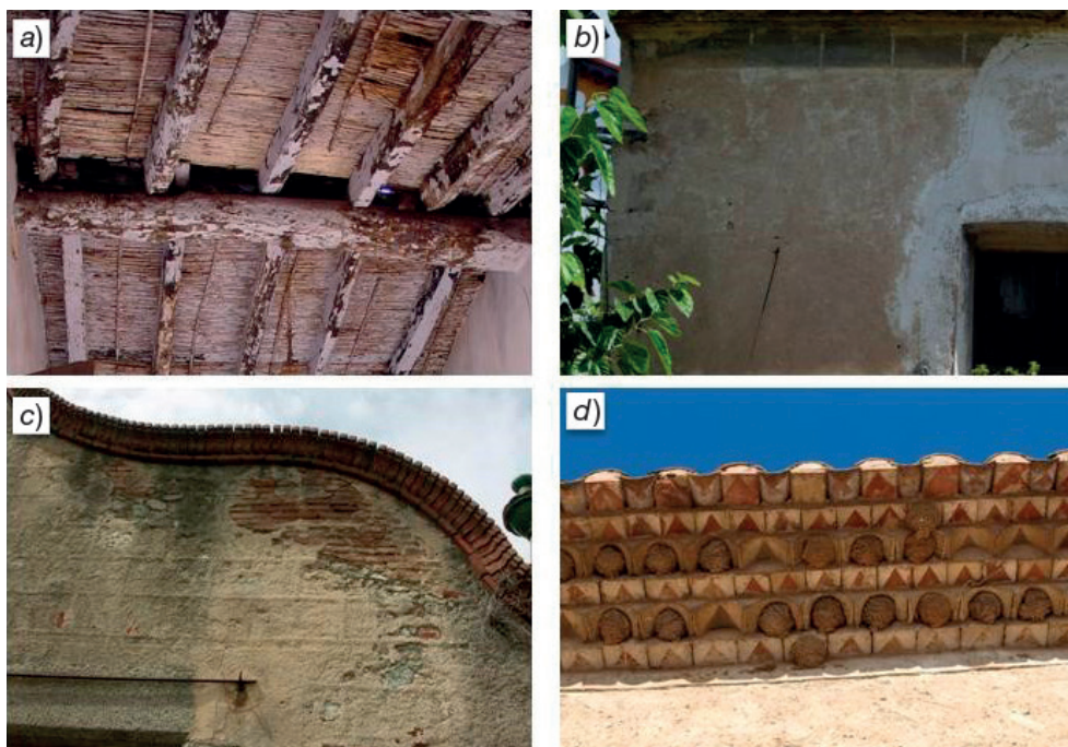
FIGURA 1. Materials que trobem a les masies: a) bigues de fusta i encanyissat (Cristina Thió, 2016), b) policromia amb sec sobre estuc (Cristina Thió, 2016), c) revestiment de calç esgrafiat (Cristina Thió, 2016) i d) voladís de ceràmica pintada (Josep M. Armengol, 2016).
