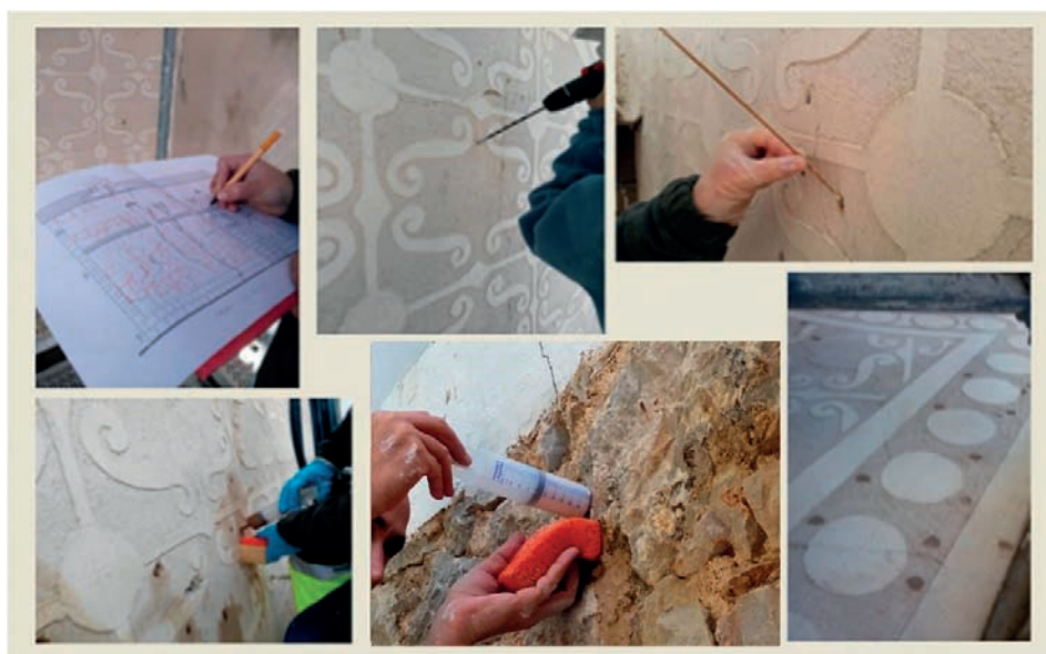
FIGURA 15. Consolidacions de parament amb injeccions de calç hidràulica (Cristina Thió, 2016).
