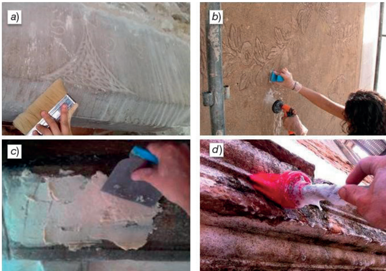
FIGURA 17. Sistemes de neteja: a) en sec, b) química, c) apòsits i d) tractament biocida (Cristina Thió, 2017, 2008 i 2015).
