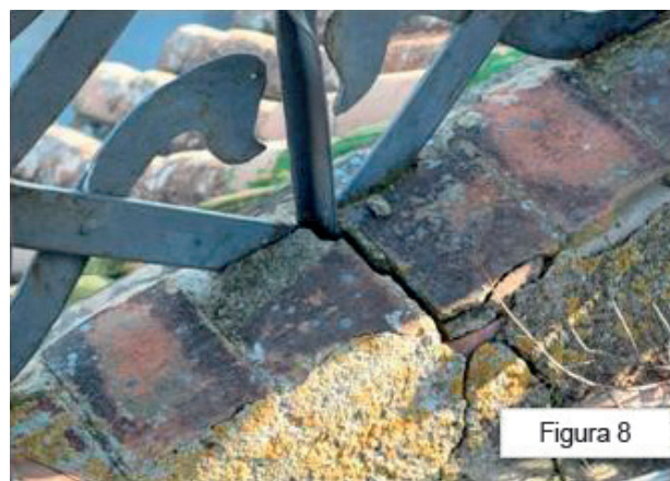
FIGURA 8. Trencament de la ceràmica per acció de l'oxidació del ferro (Cristina Thió, 2015).
