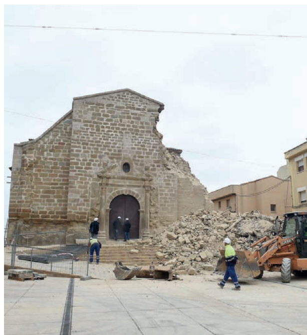
FIGURA 11. Església de Sant Pere, a Rosselló (Segrià) després de l'ensorrament de la torre del campanar i les parts inferiors (fotografia del diari El Punt Avui ).
