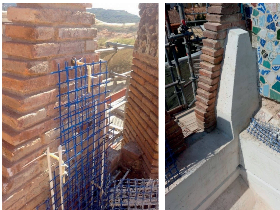
FIGURA 9. Detalls del reforç dels merlets i encercolat perimetral de la Casa Puig i Cadafalch, a Argentona. A l'esquerra, connectors i armadura de fibra de vidre. A la dreta, elements ja formigonats (fotografies dels autors).
