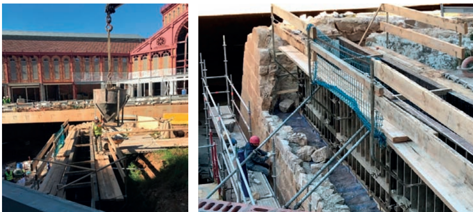
FIGURA 10. Procés seguit per formigonar el baluard de la muralla medieval de Barcelona, sota el mercat de Sant Antoni.
