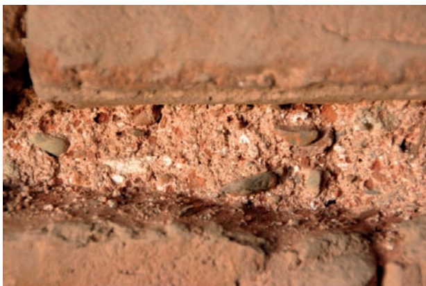
FIGURA 2. Detall d'una junta de morter de calç amb picadís en una fàbrica de maó de l'Alhambra de Granada (fotografia dels autors).
