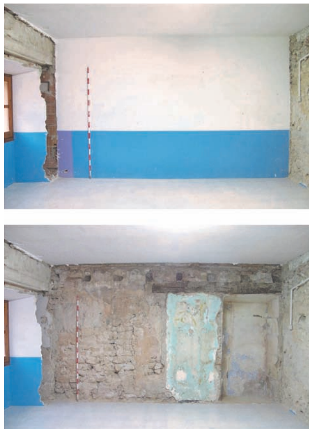
FIGURA 3. Per poder portar a terme un estudi i anàlisi parietal, generalment cal procedir a una actuació física sobre l'estructura murària que és objecte d'estudi. Aquest treball requereix una intervenció acurada per poder localitzar i identificar totes les parts que el constitueixen, tant pel que fa als revestiments com a l'aparell constructiu. (Estudi parietal de les estructures muràries de l'ala septentrional del castell de Rodonyà. Isidre Pastor, 2014.)
