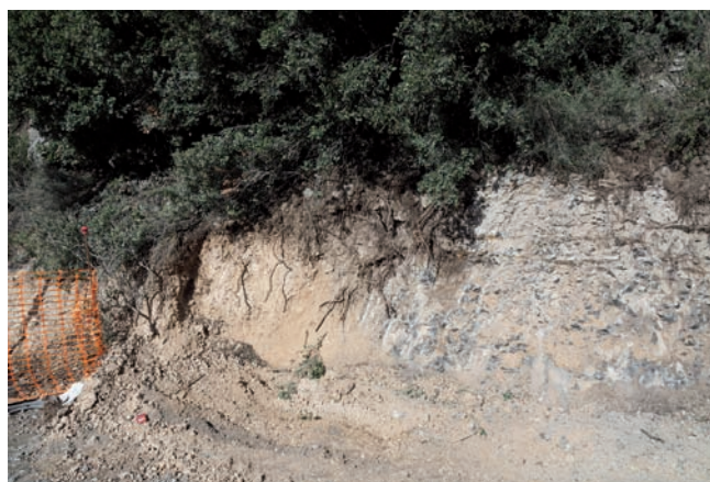
Figura 3. Zona de la carretera C-14 on ha estat eliminada la població de S. glutinosa per efectes de l'ampliació de la calçada.
