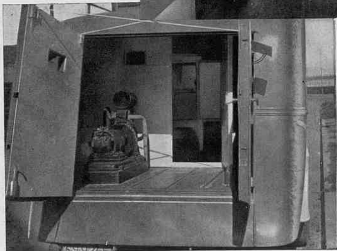
Camión dedicado al transporte de la sangre. Detalle de las neveras. Detalle del grupo electrógeno.
