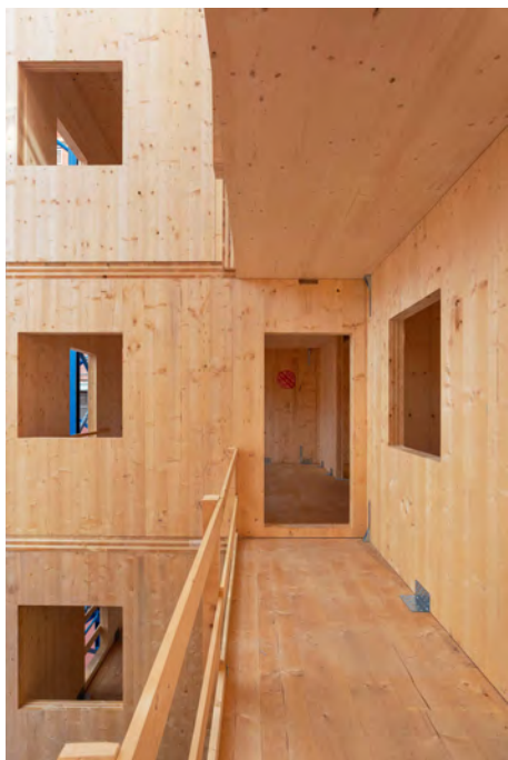
FIGURA 31. Detall de l'edifici en obra. FONT: Guifré de Peray | Celobert Cooperativa.
