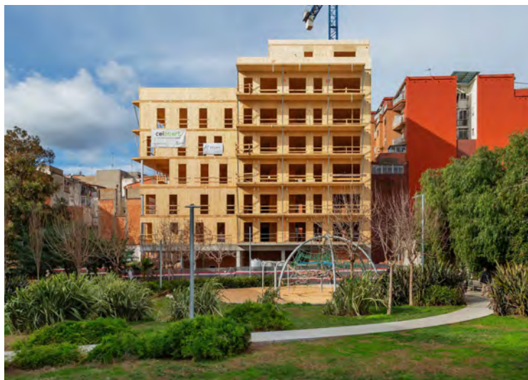
FIGURA 32. Imatge general de l'edifici en obra. FONT: Guifré de Peray | Celobert Cooperativa.
